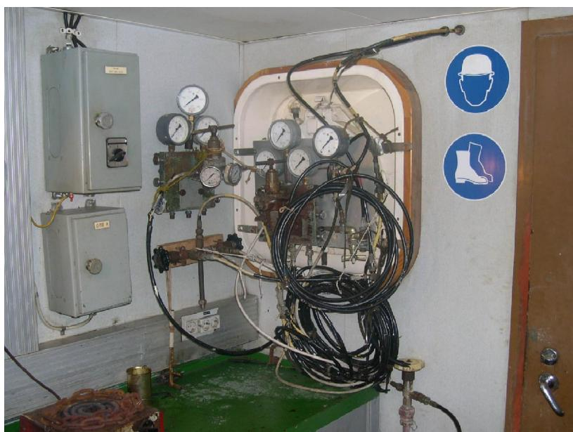
Рис. 2.2.2. Система подачи сжатого воздуха из ресивера (румпельное помещение) через кормовую лабораторию в камеры пневмоисточников. (Фото - Соколов С.Ю., 2006)
